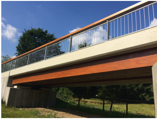
(a) Seitenansicht der Brücke
