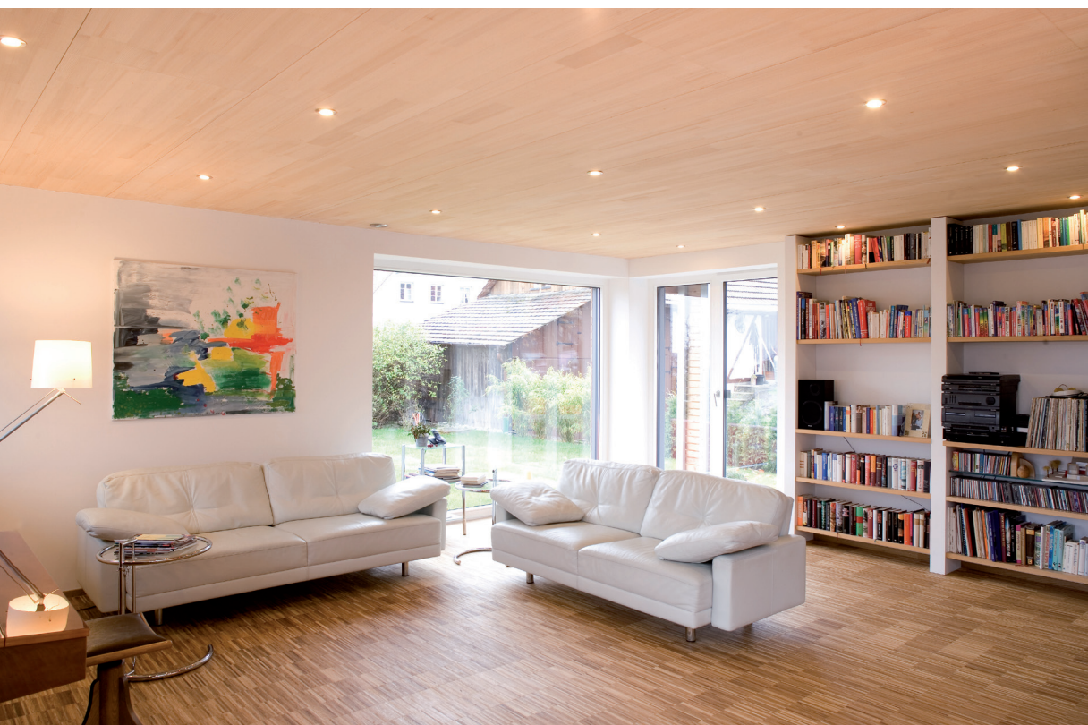
Abb. 3.1: Beispiel einer Deckenkonstruktion mit Brettsperrholz-Rippenelementen aus Weisstannenholz
